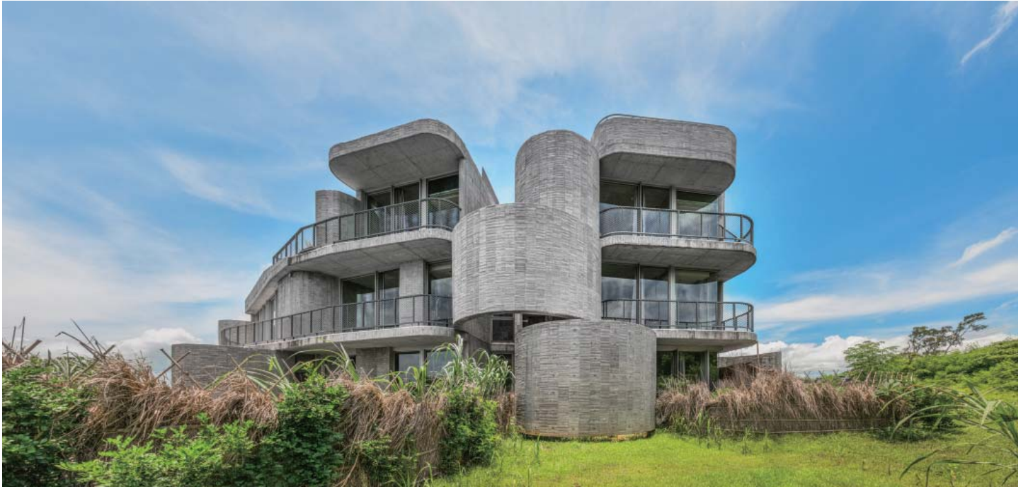
左頁：牆線相互交錯，好似牆體在南國草原上自在漫遊 右頁：樓梯間可瞥見飛牆交錯的空隙，創造出粗獷灰調與藍天相互交織的幻境
