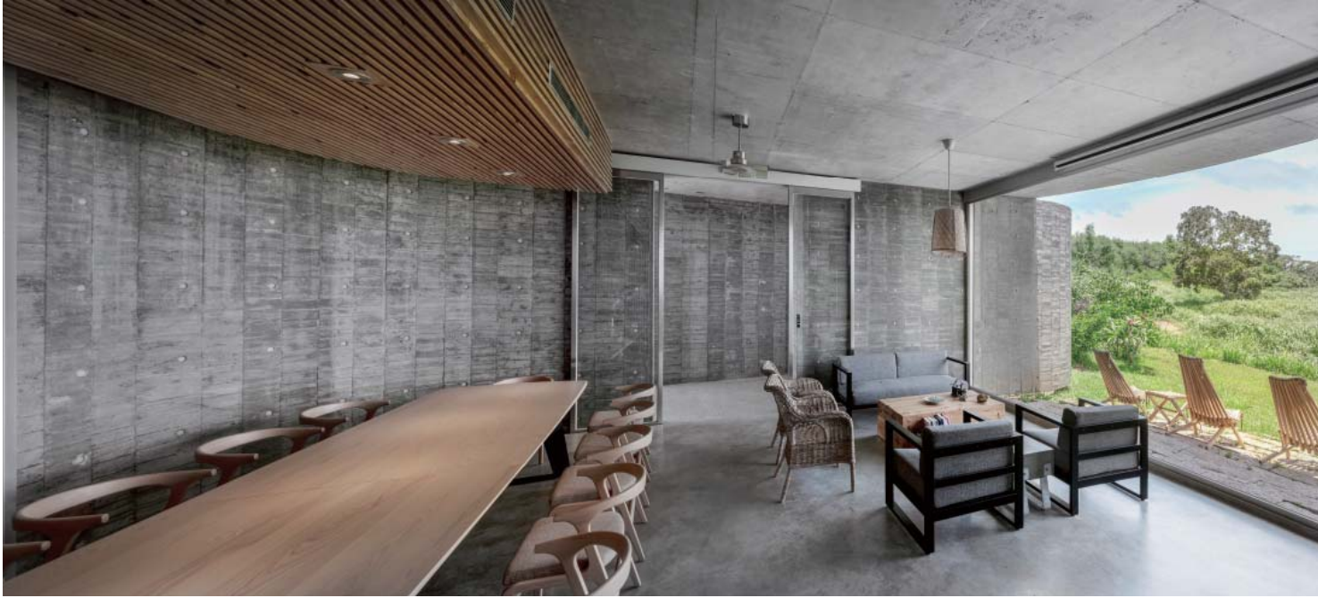
左頁・右頁：板模灌漿工法做建築結構，以牆面幅度的轉折，擘劃一體成形的內外分界
